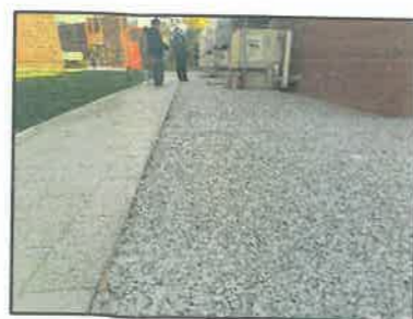
透水混凝土铺装
