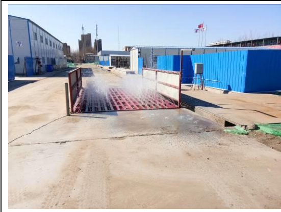
图 4-11 施工出入口洗车机
