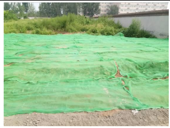
图 12 临时堆土密目网苫盖 (1)
