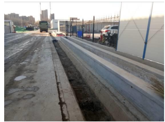
图 4-16 临时砖砌排水沟 (2)
