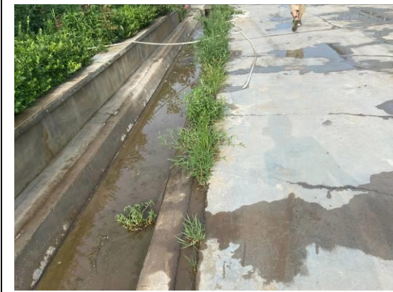
图 4-15 临时砖砌排水沟 (1)
