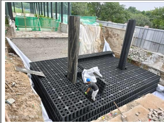
图 4-3 7#楼北侧雨水调蓄池
