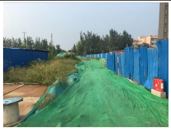
图 18 临时堆土彩钢板拦挡 (2)
