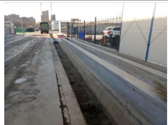
图 16 临时砖砌排水沟 (2)
