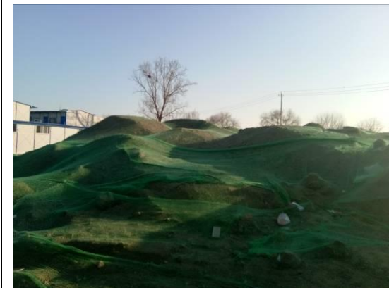
图 13 临时堆土密目网苫盖 (2)
