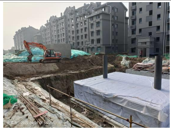
图 4-4 10#楼东北侧雨水调蓄池
