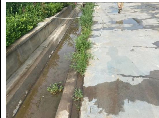
图 15 临时砖砌排水沟 (1)
