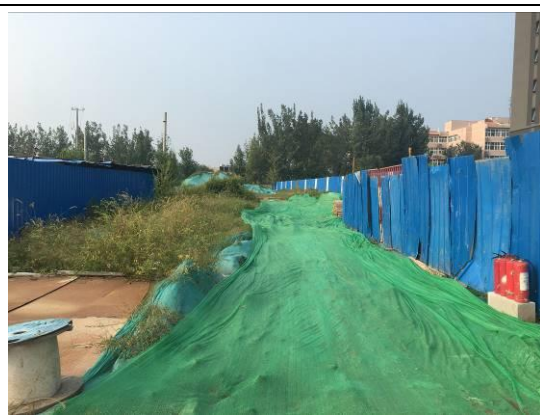
图 4-18 临时堆土彩钢板拦挡（2）
