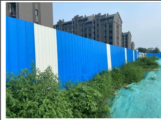
图 17 临时堆土彩钢板拦挡 (1)
