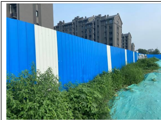
图 4-17 临时堆土彩钢板拦挡（1）
