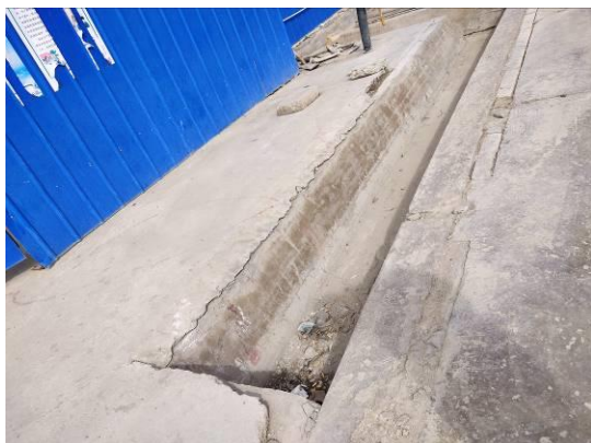
图3-19 临时砖砌排水沟（1）
