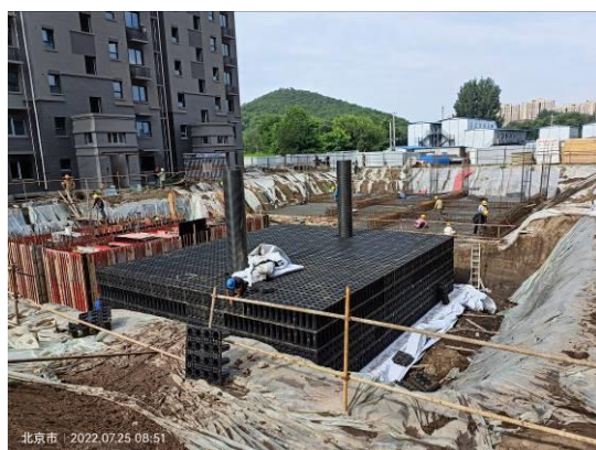
图3 10#楼东北侧雨水调蓄池 (1)
