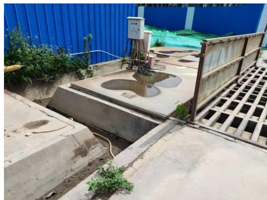
图3-20 临时砖砌排水沟（2）
