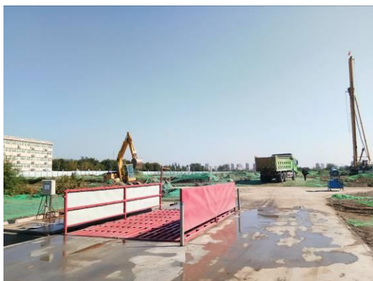
图3-15 施工出入口洗车机
