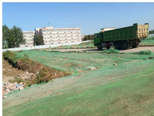
图3-16 临时堆土密目网苫盖（1）
