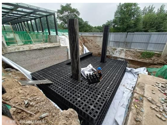
图3-5 7#楼北侧雨水调蓄池（1）
