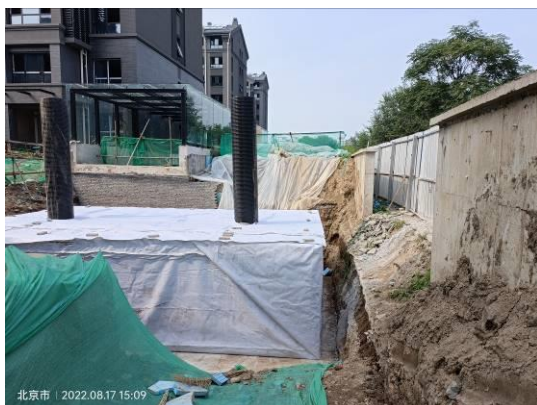
图3-6 7#楼北侧雨水调蓄池（2）
