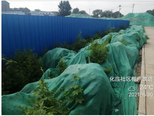
图3-21 临时堆土彩钢板拦挡（1）
