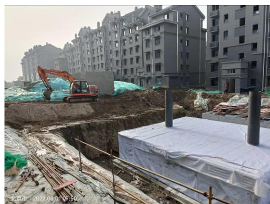
图4 10#楼东北侧雨水调蓄池 (2)
