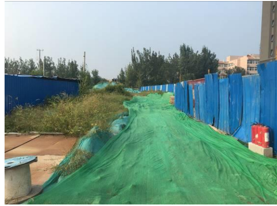
图3-22 临时堆土彩钢板拦挡（2）
