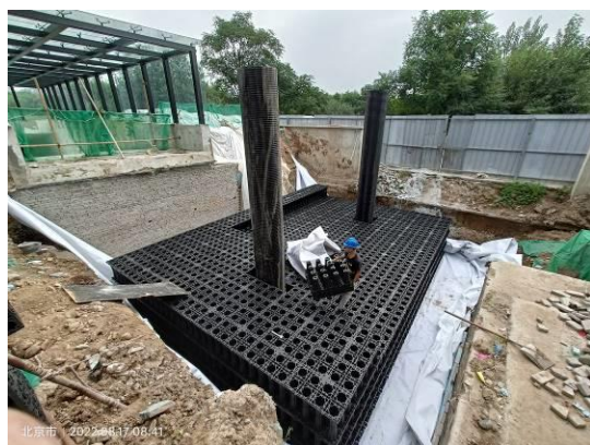
图1 7#楼北侧雨水调蓄池 (1)
