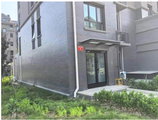
图11 建筑物周边集雨式绿地 (1)
