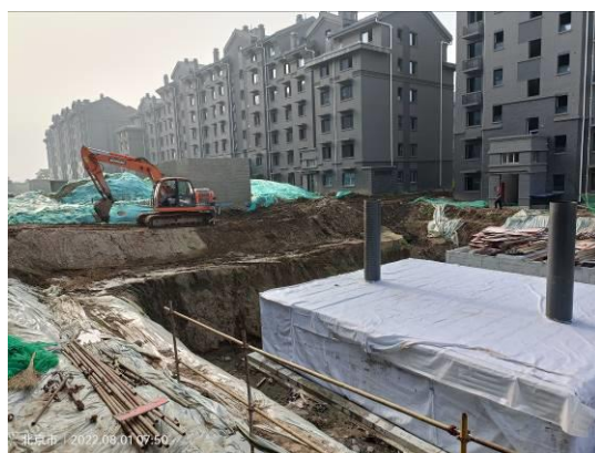
图3-8 10#楼东北侧雨水调蓄池（2）
