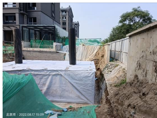
图2 7#楼北侧雨水调蓄池 (2)
