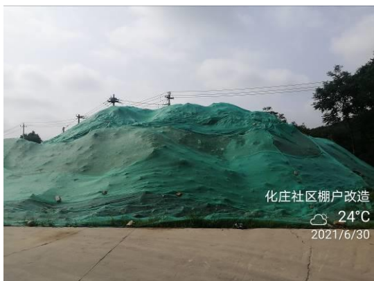
图3-17 临时堆土密目网苫盖（2）
