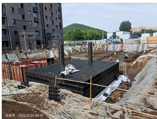
图3-7 10#楼东北侧雨水调蓄池（1）
