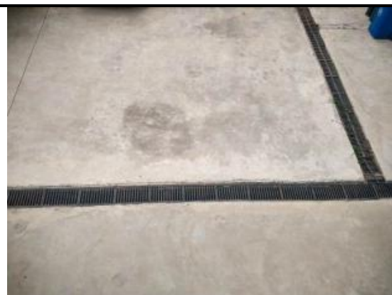
图4-22 临时排水沟 (2016年8月)
