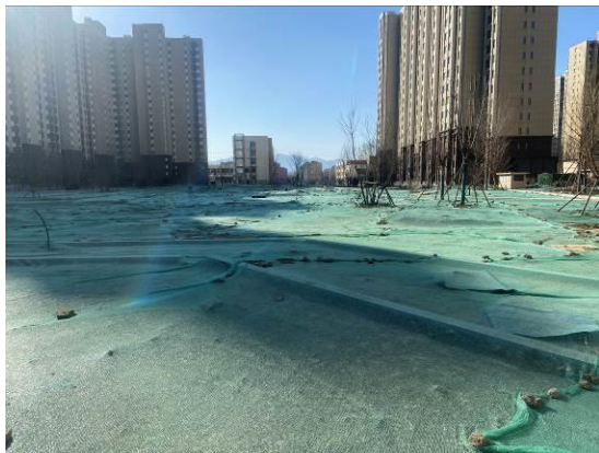
临时苫盖（2022年9月）
