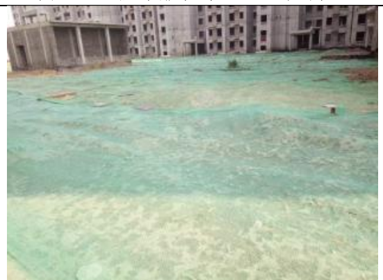
图4-24 临时苫盖 (2016年12月)
