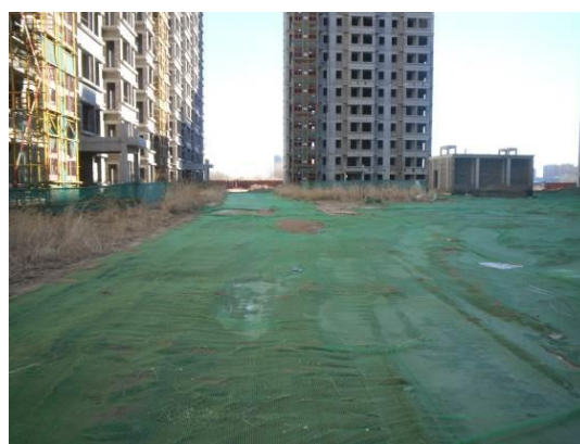
临时苫盖（2016年12月）
