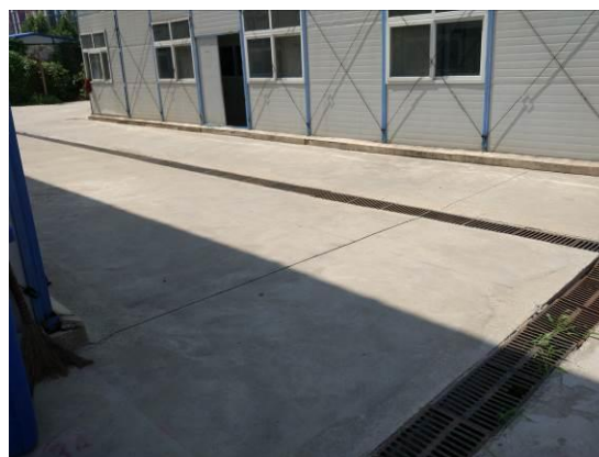
临时排水沟（2017年8月）
