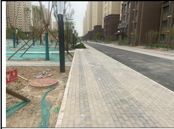
图4-7 步行道透水砖铺装 (2023年4月)
