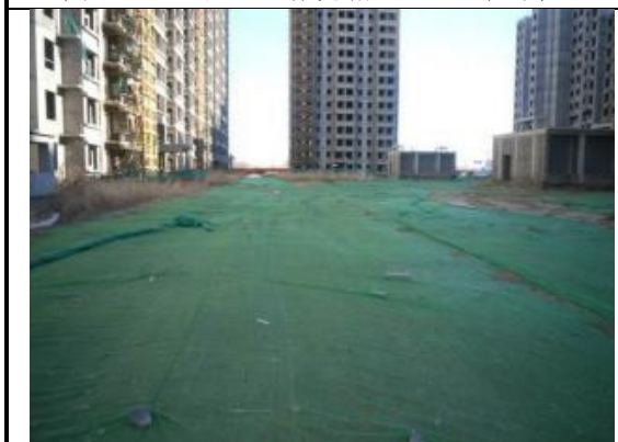
图4-23 临时苫盖 (2016年12月)
