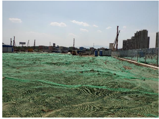
临时苫盖 (2019年5月)
