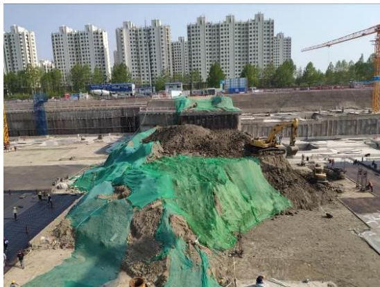
临时苫盖 (2020年4月)
