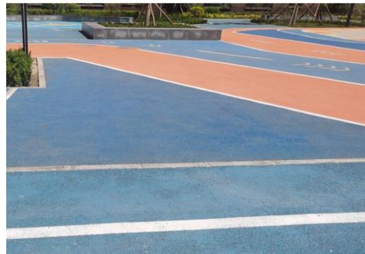
图 3.5-5 透水混凝土
