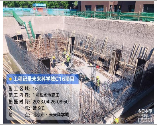
图 8 1#雨水调蓄池施工 2023.04
