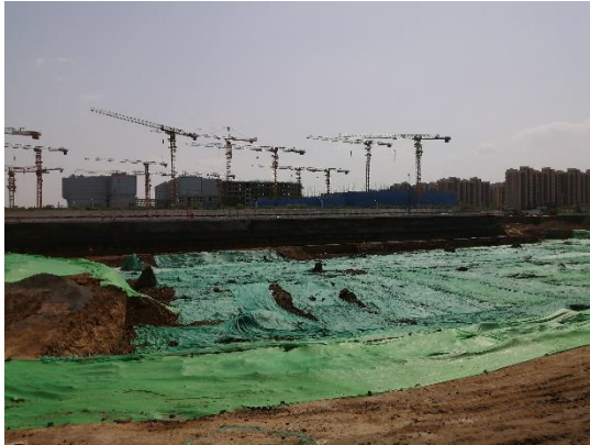
图 4-11 裸露地表临时苫盖 2020.02
