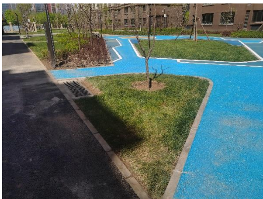
图4-5 彩色透水混凝土
