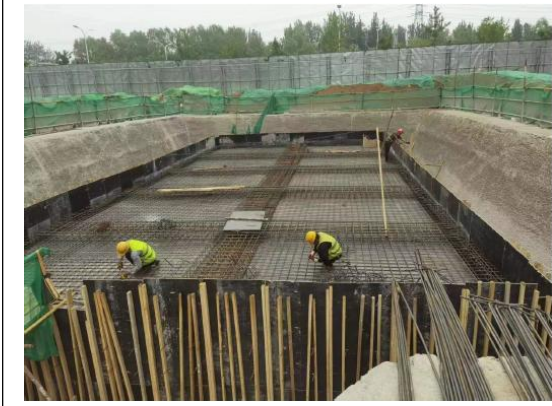
图 9 2#雨水调蓄池钢筋绑扎 2023.04
