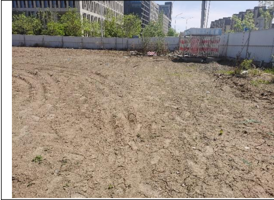
图 15 施工临建区撒播草籽 2023.08
