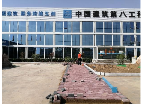
图 4-14 临时绿化和临时透水铺装 2020.02
