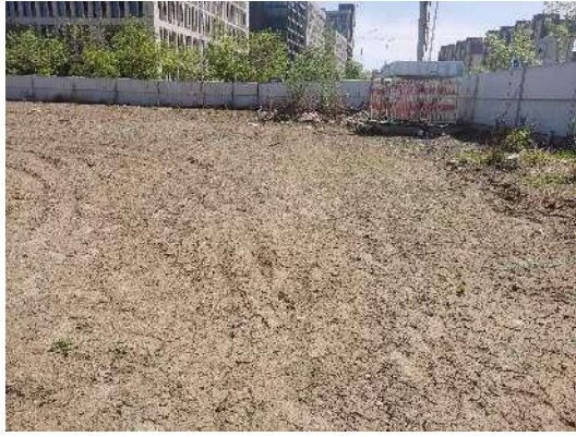
图4-7 施工临建区土地整治
