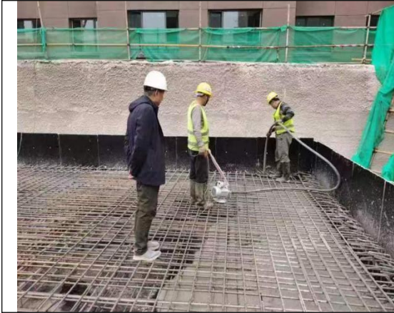
图 7 1#雨水调蓄池混凝土浇筑 2023.04
