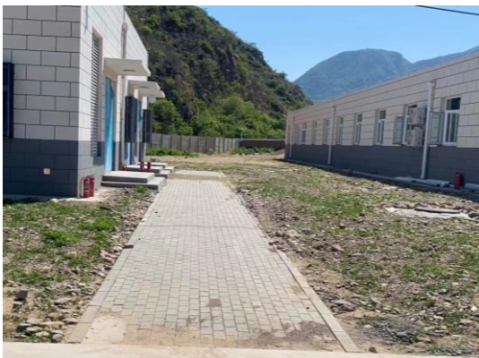
图3-2 透水砖铺装（一）
