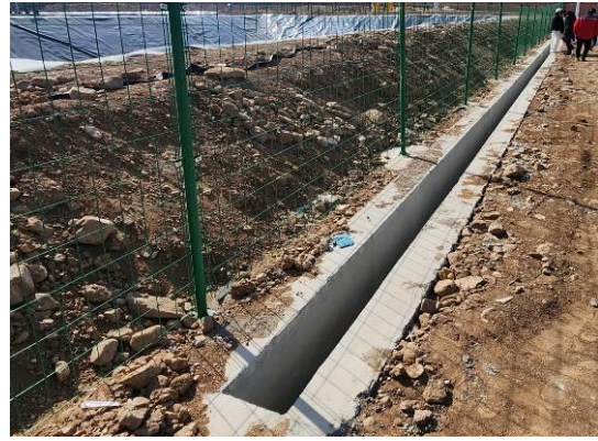
图3-11 临时排水沟（二）
