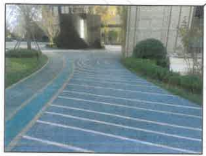
透水塑胶及混凝土铺装
