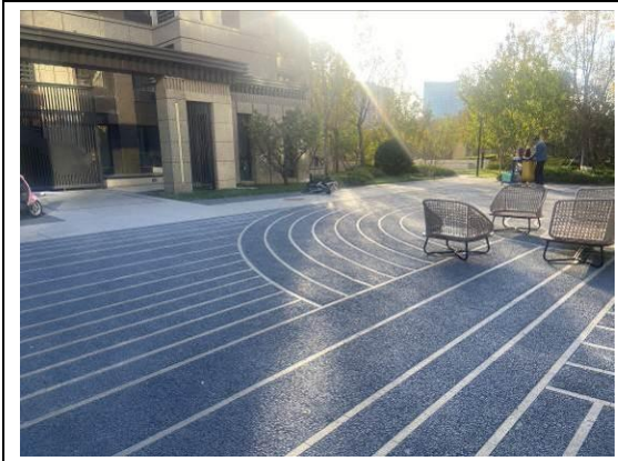
图 1 透水砖混凝土及塑胶铺装 (2)
