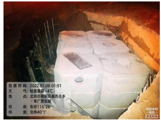
图 4-4 7#楼南侧雨水调蓄池
