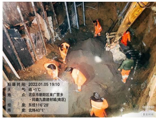
图 4 7#楼南侧雨水调蓄池
