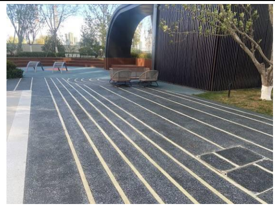
图 4-2 透水混凝土及塑胶铺装 (3)
