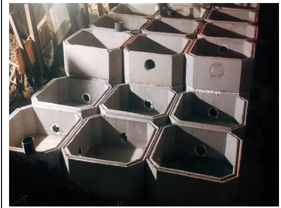
图 3 1#楼南侧雨水调蓄池
