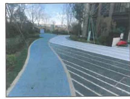
透水塑胶及混凝土铺装
