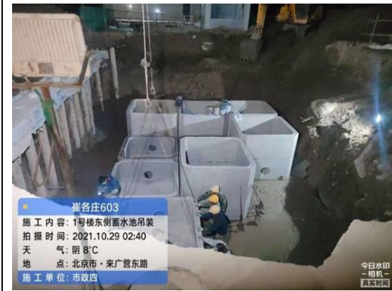
图 4-5 1#楼东侧雨水调蓄池
