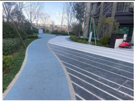
图 4-2 透水砖混凝土及塑胶铺装 (1)
