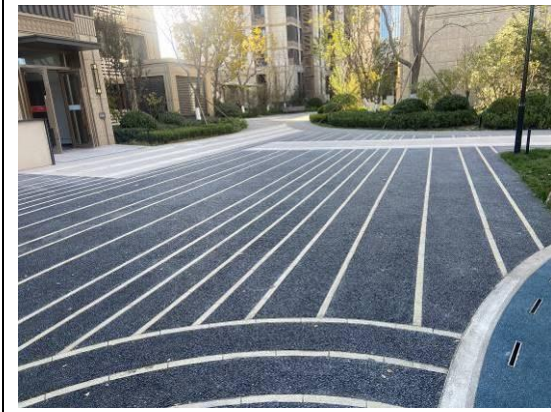
图 4-3 透水砖混凝土及塑胶铺装 (2)
