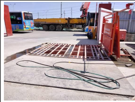
图 4-15 洗轮机沉淀池
