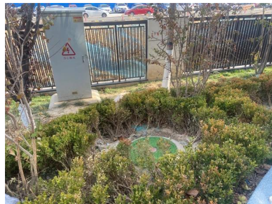
图4 4#楼南侧雨水调蓄池 (2)
