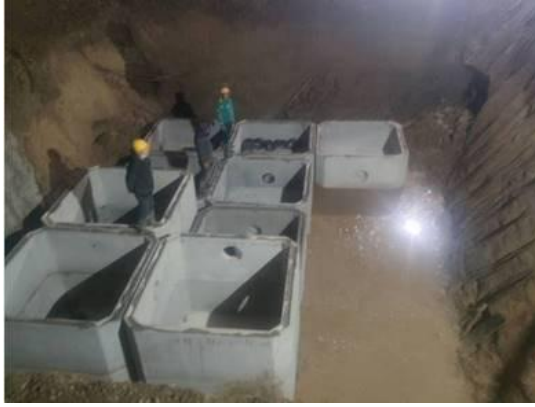
图3-9 4#楼南侧雨水调蓄池施工（1）
