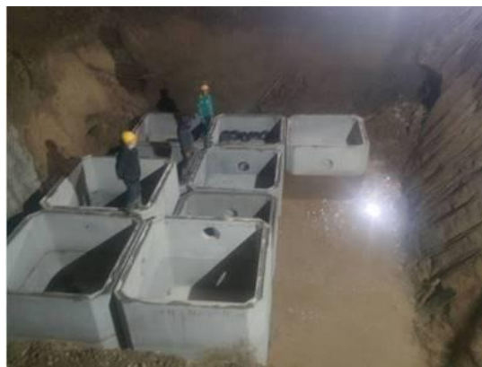
图3 4#楼南侧雨水调蓄池 (1)
