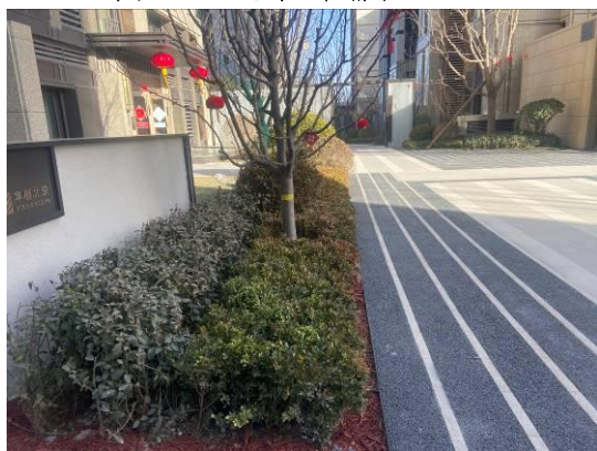
图3-5 透水混凝土及塑胶铺装（1）
