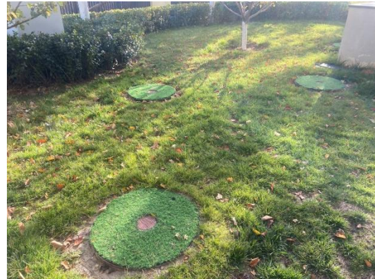
图2 1#楼东侧雨水调蓄池 (2)
