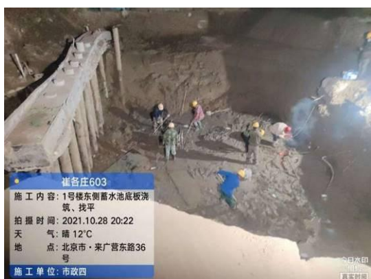
图3-7 1#楼东侧雨水调蓄池施工（1）
