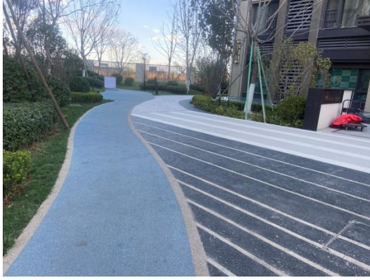
图7 透水混凝土及塑胶铺装 (1)
