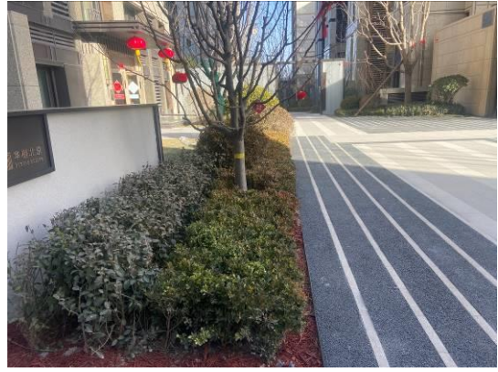
图8 透水混凝土及塑胶铺装 (2)
