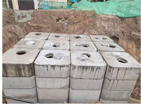
图3-10 4#楼南侧雨水调蓄池施工（2）
