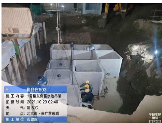
图3-8 1#楼东侧雨水调蓄池施工（2）
