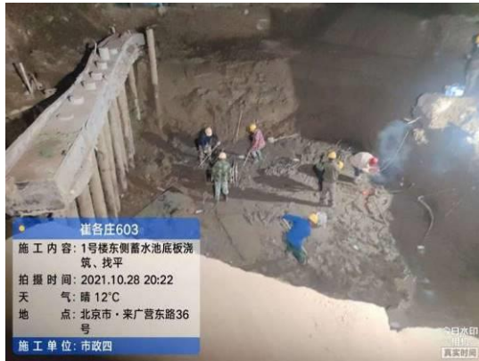
图1 1#楼东侧雨水调蓄池 (1)
