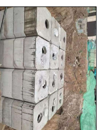
4#楼南侧蓄水池
