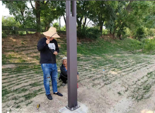
图 12 自然草坡驳岸 2023.06
