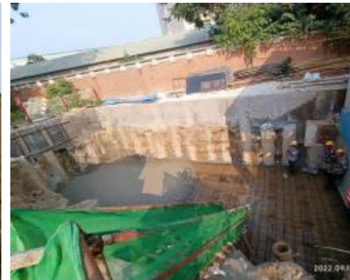
图4-6 雨水调蓄池施工
