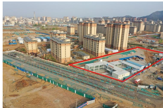
E 地块东侧办公生活区尚未拆除 (2023 年 6 月)
