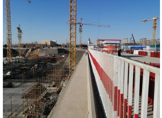
临时措施：基坑挡水梗
