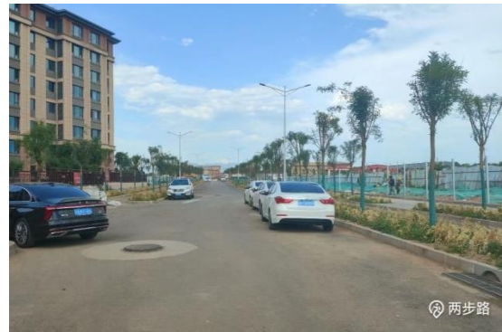
E南侧便道与生产区已腾退并正在用于新宝路建设(2023年6月)
