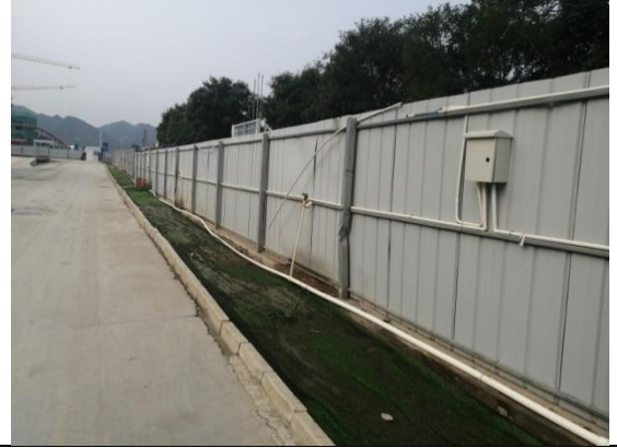
临时措施：临时排水沟
