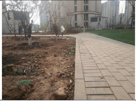
工程措施：绿化整地（F地块）
