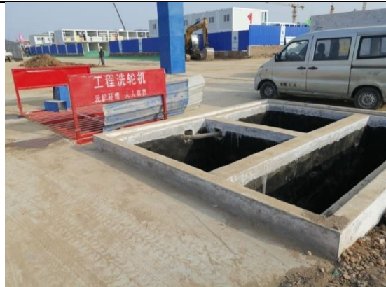
临时措施：洗车沉淀池
