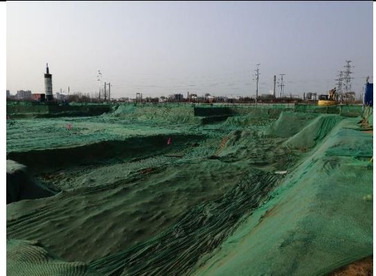
临时措施：密目网苫盖（F地块）
