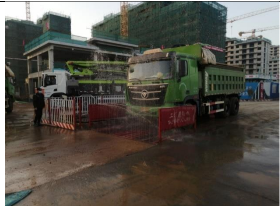
临时措施：洗车沉淀池
