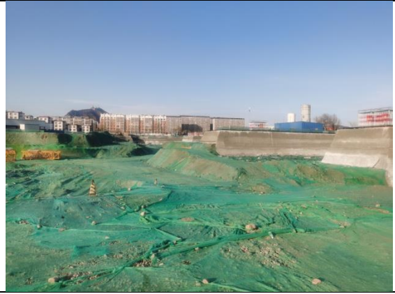
临时措施：密目网苫盖（H地块）
