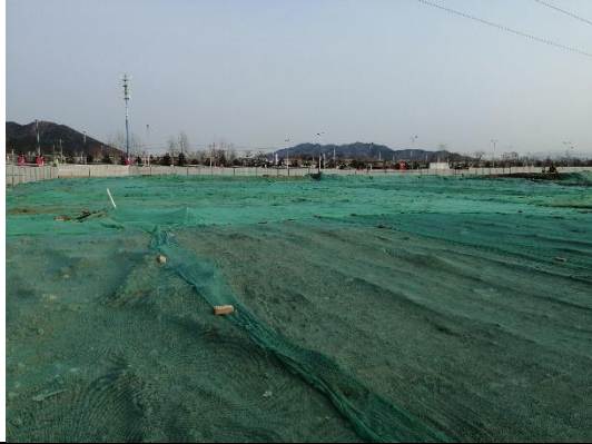
临时措施：密目网苫盖（A地块）
