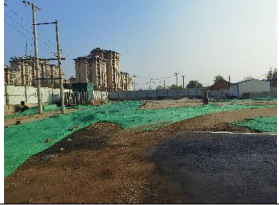
工程措施：临时用地土地整治
