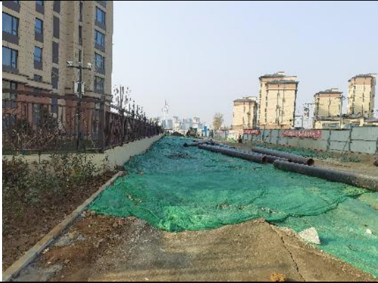
工程措施：临时用地土地整治
