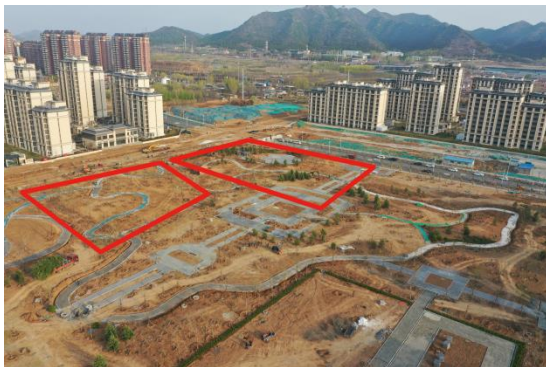
A、B、F、G 办公生活区已拆除恢复并移交 (2023 年 6 月)
