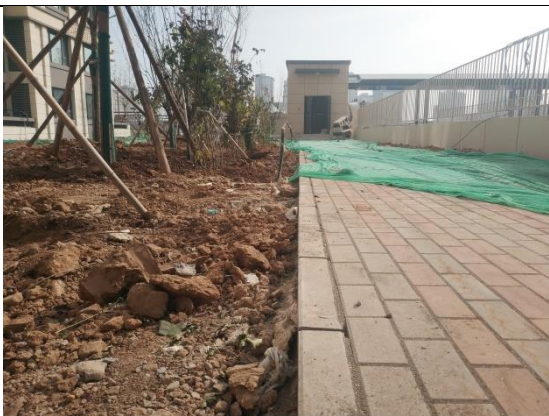
工程措施：绿化整地（D地块）
