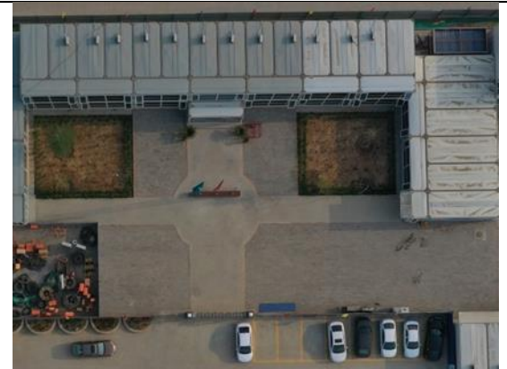
临时措施：透水砖铺装
