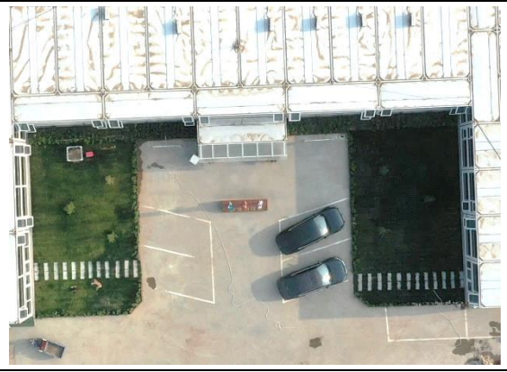
临时措施：临时绿化（A、B地块办公生活区）
