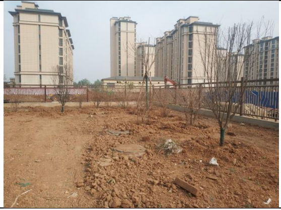
工程措施：绿化整地（A地块）
