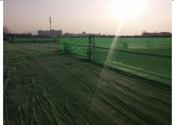
临时措施：密目网苫盖（D地块）
