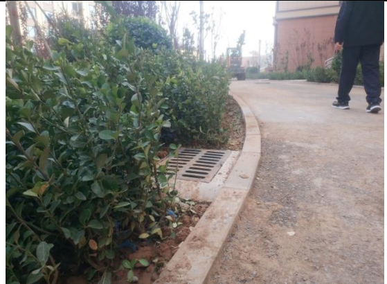
工程措施：绿化整地（H地块）
