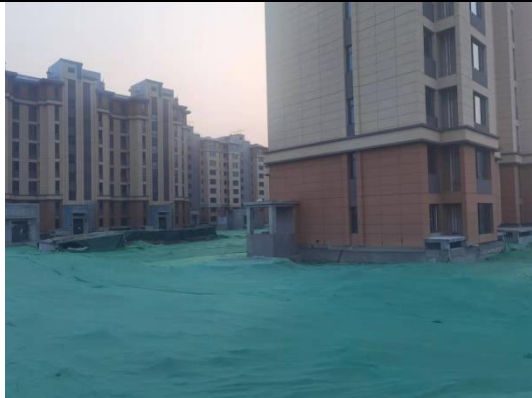
临时措施：密目网苫盖（E地块）
