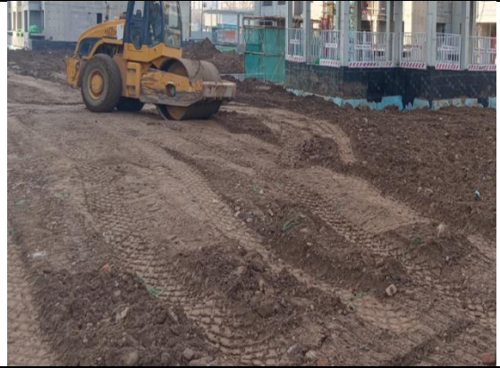
工程措施：临时用地土地整治
