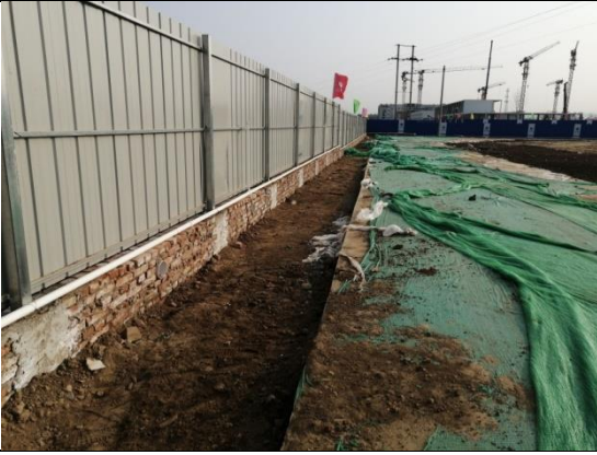
临时措施：临时排水沟
