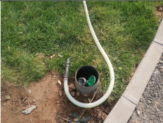
工程措施：节水灌溉（E地块）
