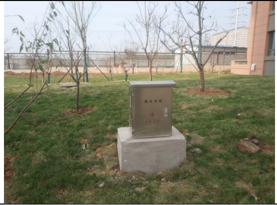
工程措施：节水灌溉（D地块）
