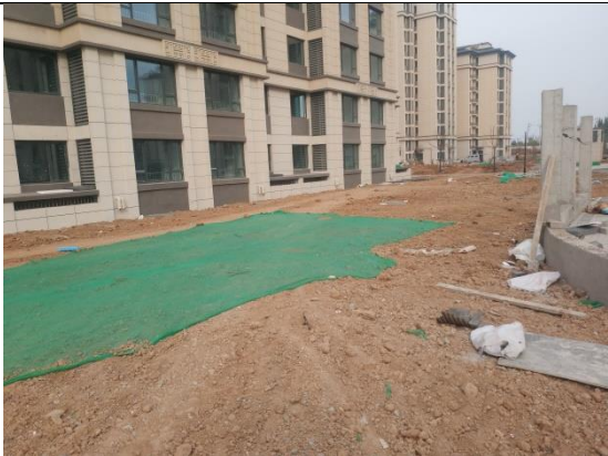
工程措施：绿化整地（C地块）
