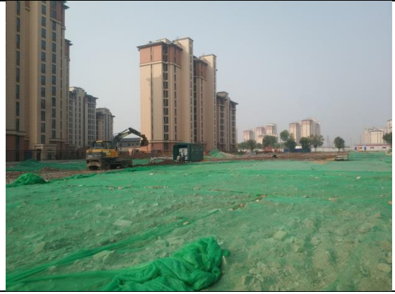
工程措施：临时用地土地整治
