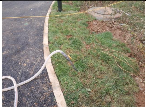
工程措施：节水灌溉（F地块）
