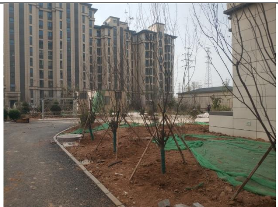
工程措施：绿化整地（D地块）
