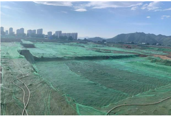
临时措施：密目网苫盖（C地块）
