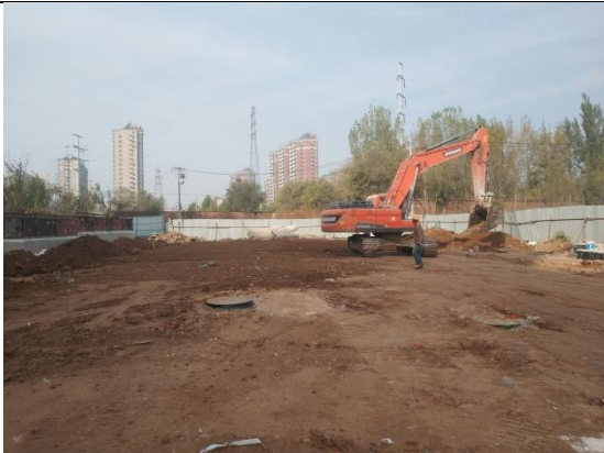
工程措施：临时用地土地整治
