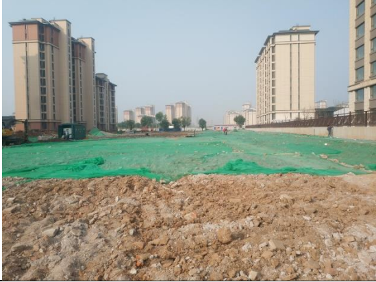
工程措施：临时用地土地整治
