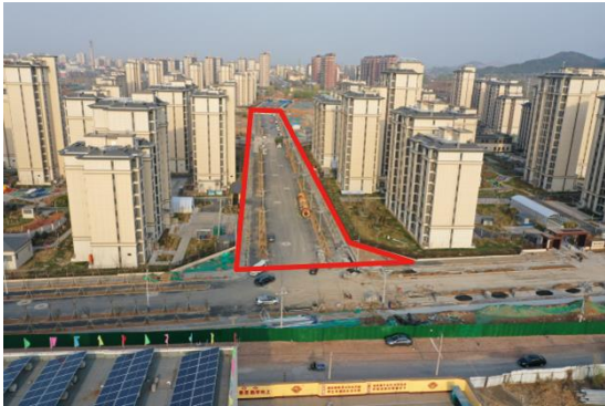
A、B南侧施工便道与生产区已腾退并正在用于新祥街建设(2023年6月)
