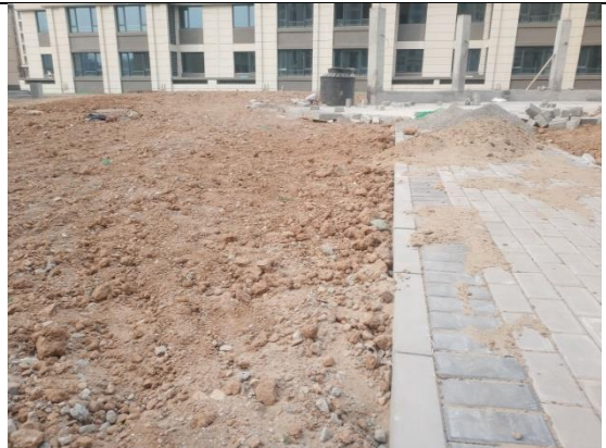
工程措施：绿化整地（C地块）
