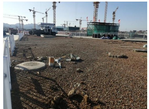
临时措施：碎石透水铺装
