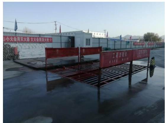
临时措施：洗车沉淀池
