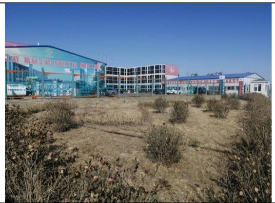
临时措施：临时绿化（G地块）
