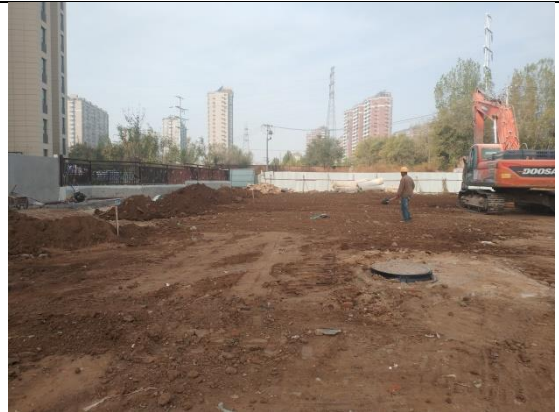
工程措施：临时用地土地整治
