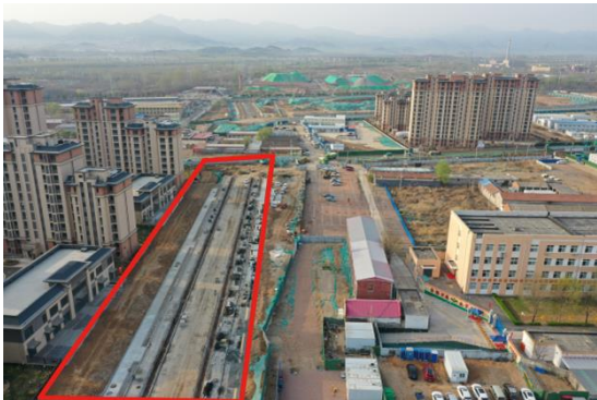
C、D西侧便道与生产区已腾退并正在用于新宝路建设(2023年6月)
