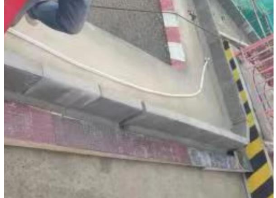
临时措施：基坑挡水梗
