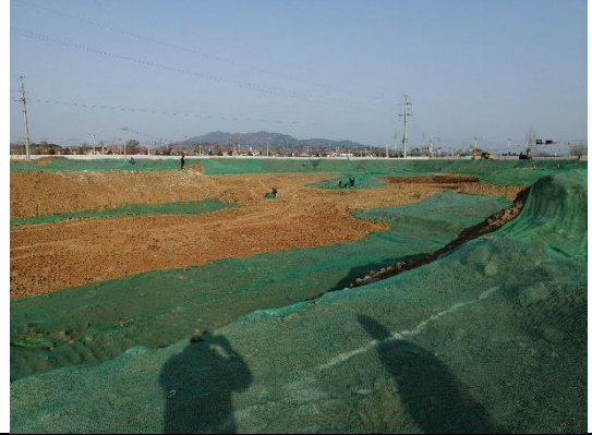
临时措施：密目网苫盖（B地块）
