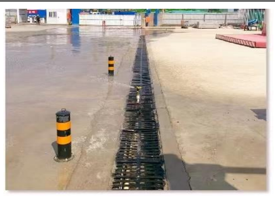
临时措施：临时排水沟
