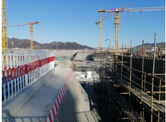
临时措施：基坑挡水梗
