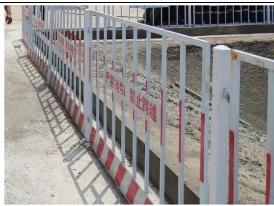
临时措施：基坑挡水梗
