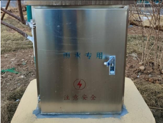
工程措施：节水灌溉（F地块）
