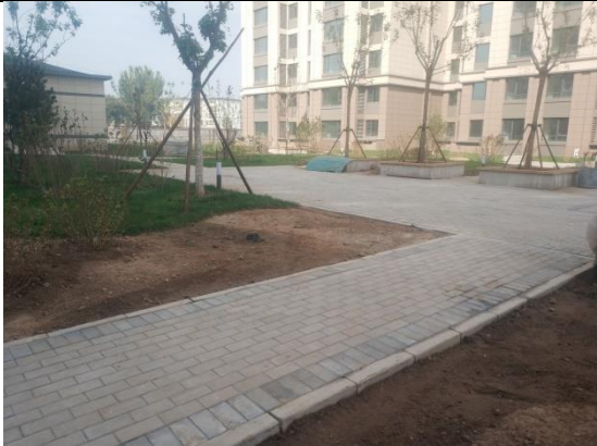
工程措施：绿化整地（H地块）
