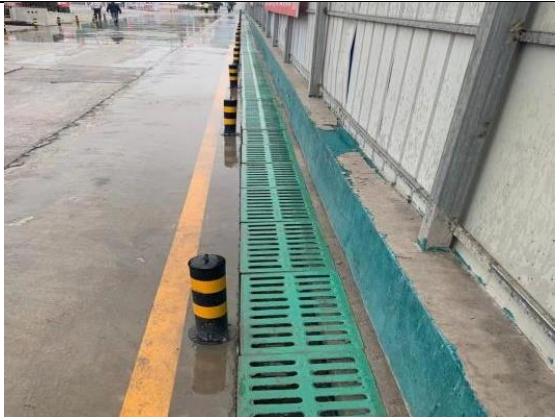
临时措施：临时排水沟
