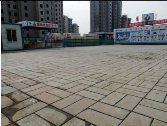
临时措施：透水砖铺装
