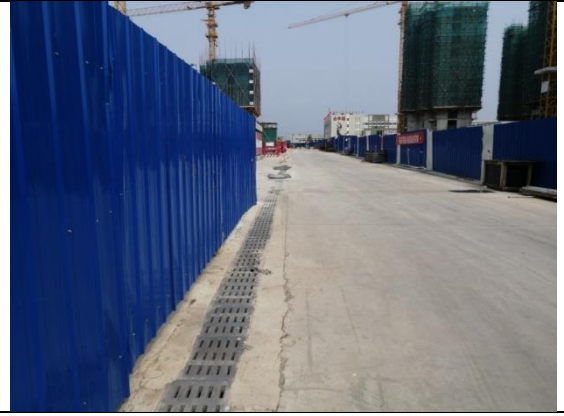
临时措施：临时排水沟
