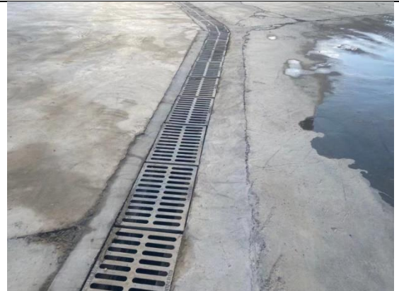
临时措施：临时排水沟
