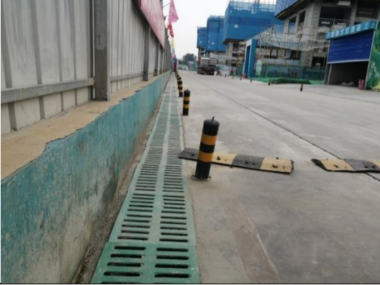
临时措施：临时排水沟
