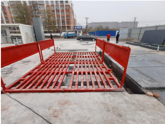
临时措施：洗车沉淀池
