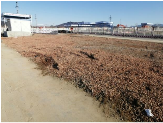
临时措施：碎石透水铺装
