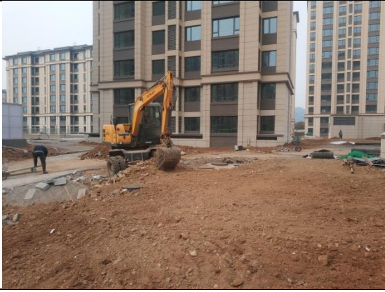
工程措施：临时用地土地整治
