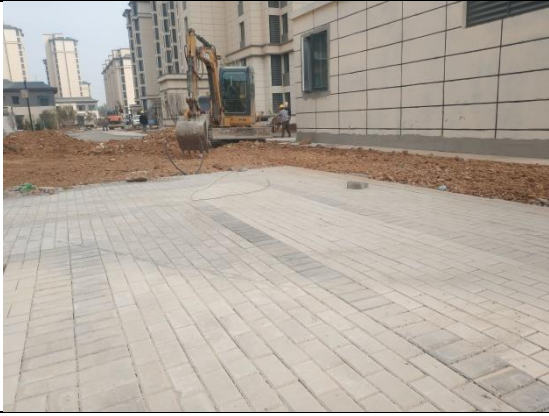
工程措施：绿化整地（A地块）
