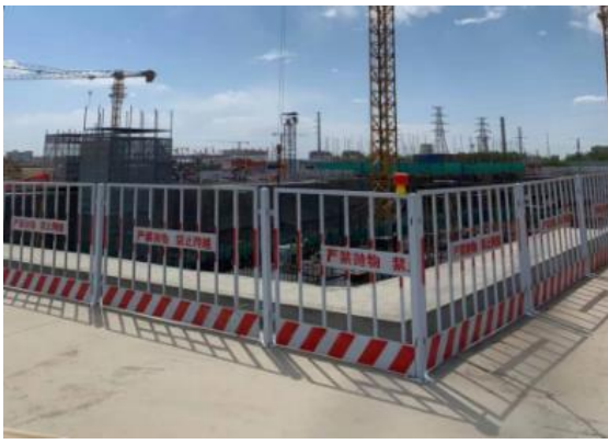
临时措施：基坑挡水梗
