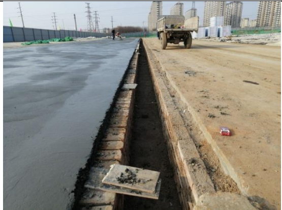
临时措施：临时排水沟
