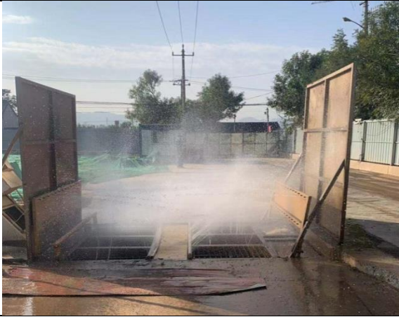
临时措施：洗车沉淀池
