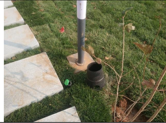
工程措施：节水灌溉（D地块）
