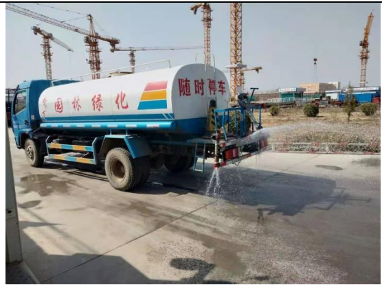
临时措施：洒水降尘
