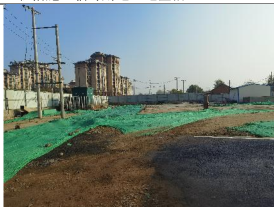
工程措施：临时用地土地整治
