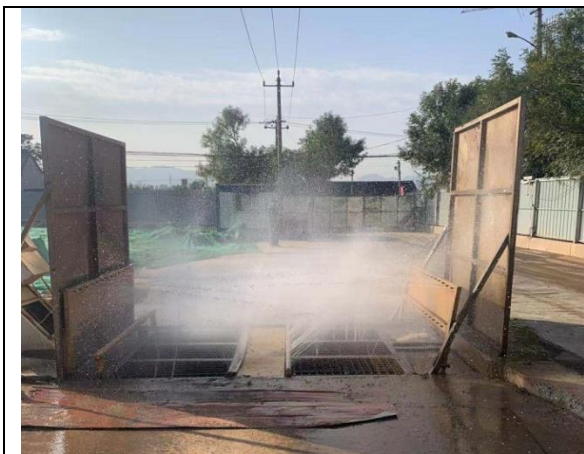
临时措施：洗车沉淀池
