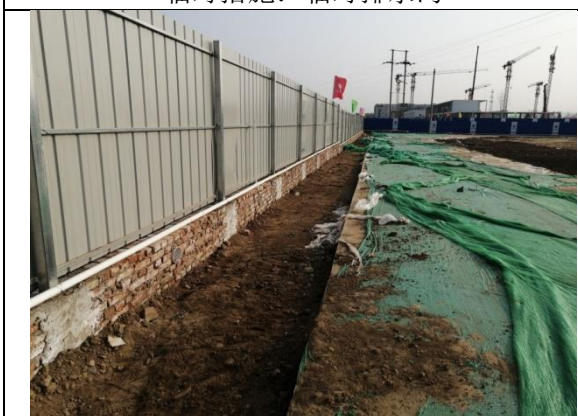
临时措施：临时排水沟
