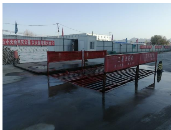
临时措施：洗车沉淀池
