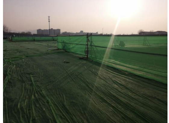
临时措施：密目网苫盖（D地块）
