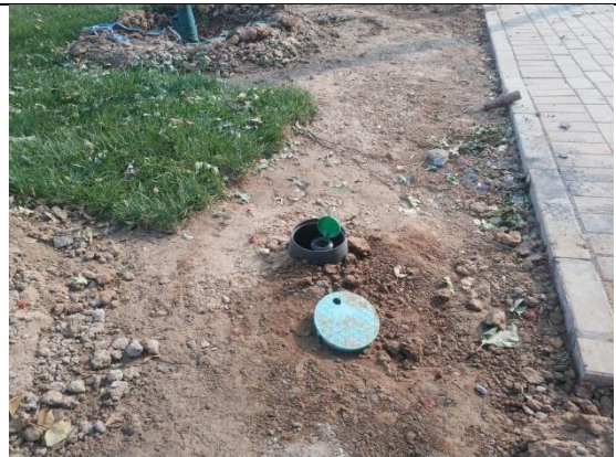
工程措施：节水灌溉（G地块）
