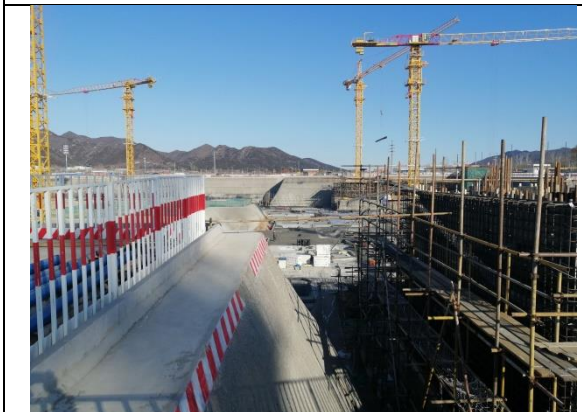
临时措施：基坑挡水梗
