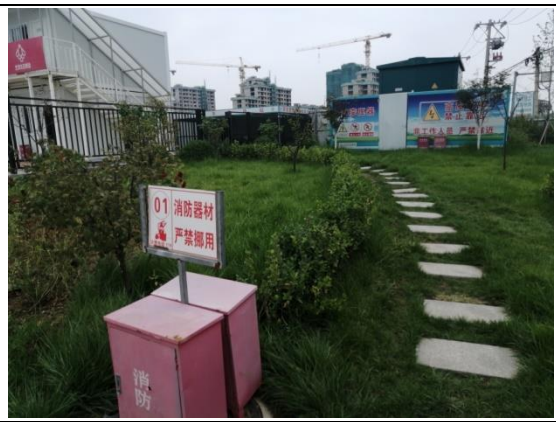
临时措施：临时绿化（F地块）
