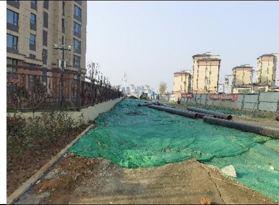
工程措施：临时用地土地整治
