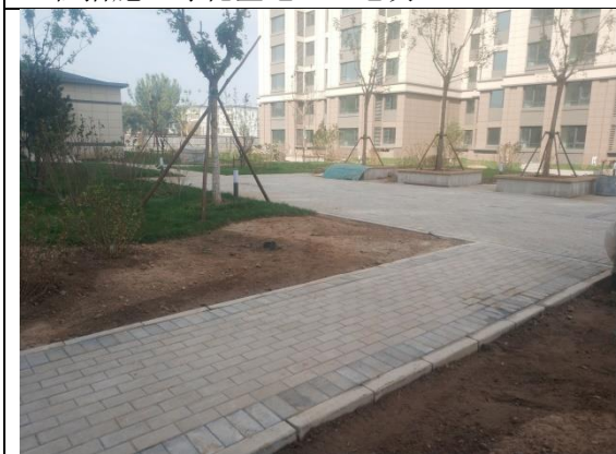
工程措施：绿化整地（H地块）
