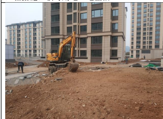
工程措施：临时用地土地整治
