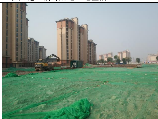
工程措施：临时用地土地整治
