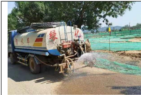
临时措施:洒水降尘
