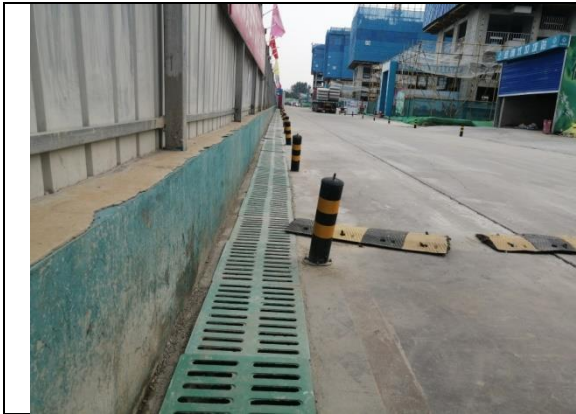
临时措施：临时排水沟
