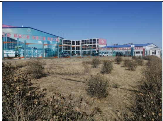
临时措施：临时绿化（G地块）
