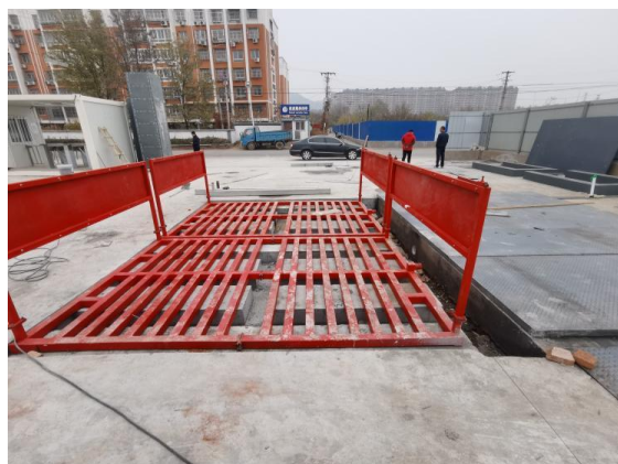
临时措施：洗车沉淀池
