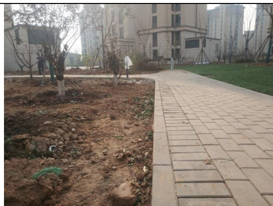
工程措施：绿化整地（F地块）
