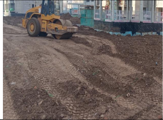
工程措施：临时用地土地整治
