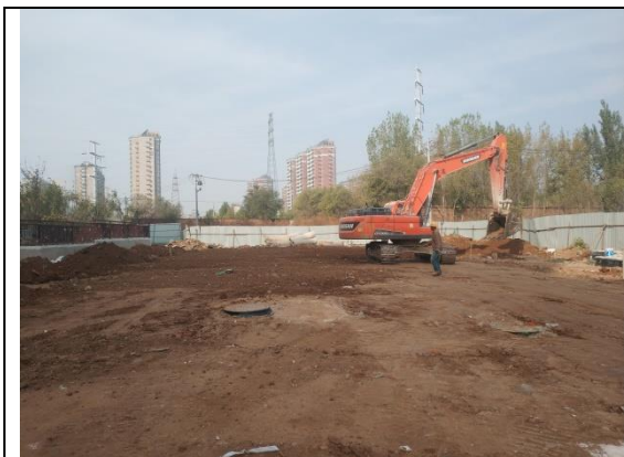
工程措施：临时用地土地整治
