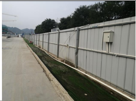
临时措施：临时排水沟
