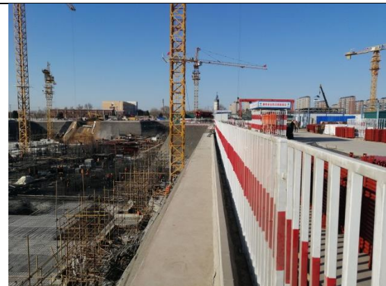
临时措施：基坑挡水梗
