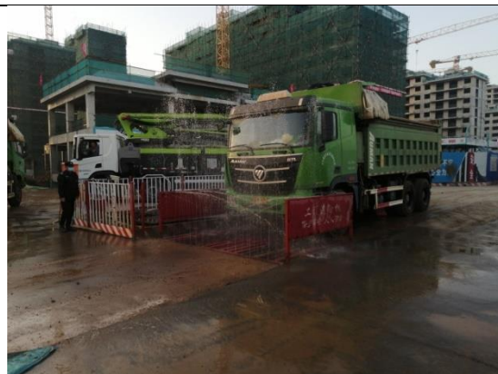
临时措施：洗车沉淀池
