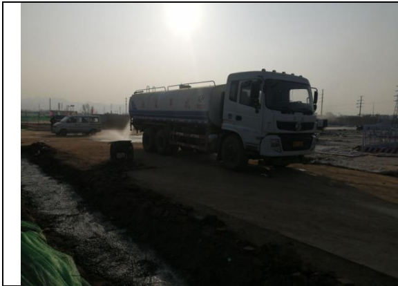
临时措施：洒水降尘
