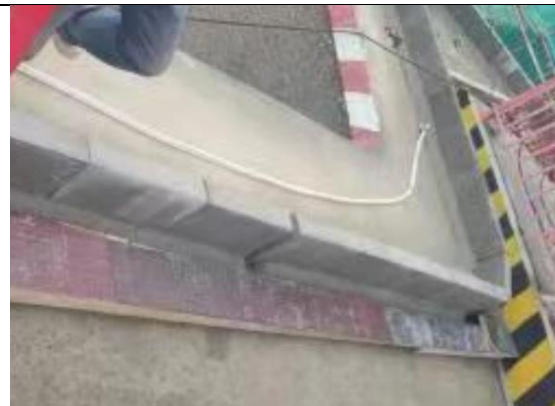
临时措施：基坑挡水梗
