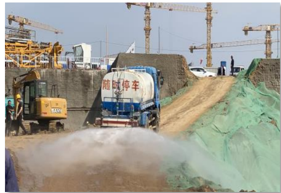
临时措施:洒水降尘
