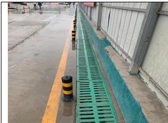
临时措施：临时排水沟
