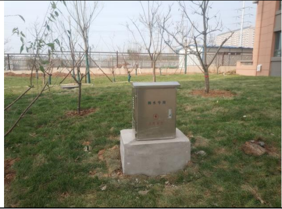
工程措施：节水灌溉（D地块）
