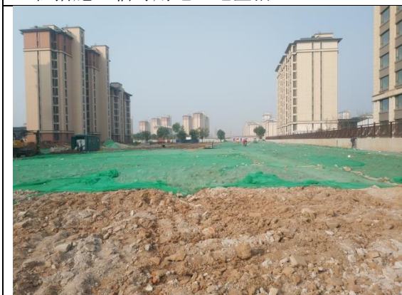
工程措施：临时用地土地整治
