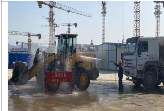
临时措施：洗车沉淀池
