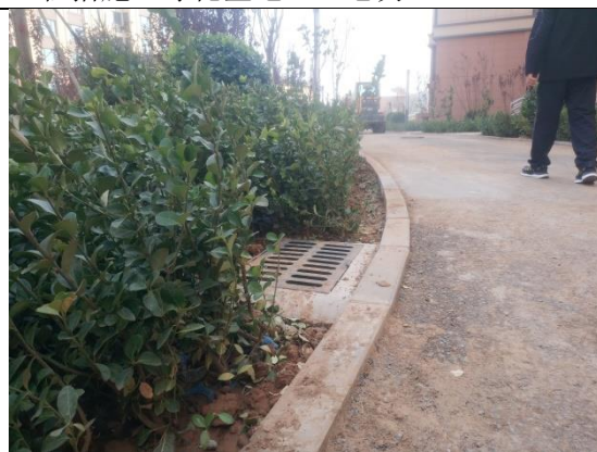
工程措施：绿化整地（H地块）
