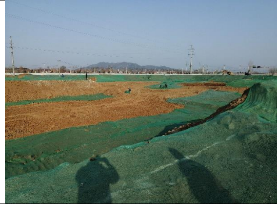
临时措施：密目网苫盖（B地块）
