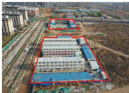
H 地块东侧办公生活区尚未拆除 (2023 年 6 月)
