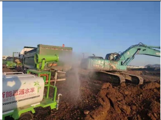
临时措施：洒水降尘
