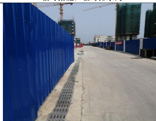
临时措施：临时排水沟
