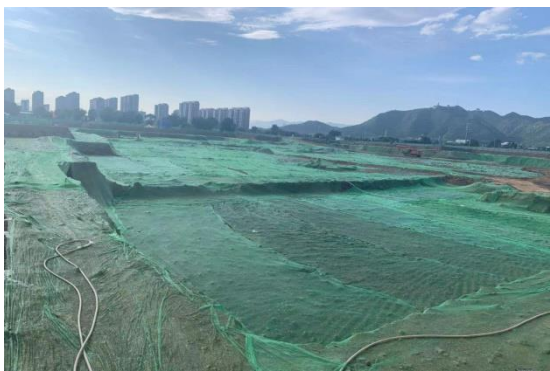
临时措施：密目网苫盖（C地块）
