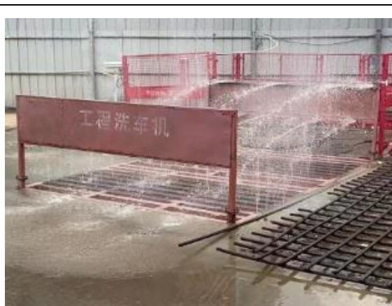
临时措施：洗车沉淀池
