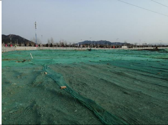
临时措施：密目网苫盖（A地块）
