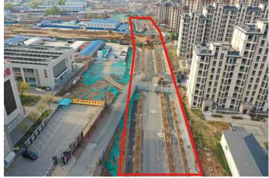
C、D 东侧便道与生产区已腾退并正在用于新泰路建设（2023 年 6 月）
