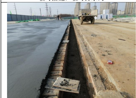
临时措施：临时排水沟
