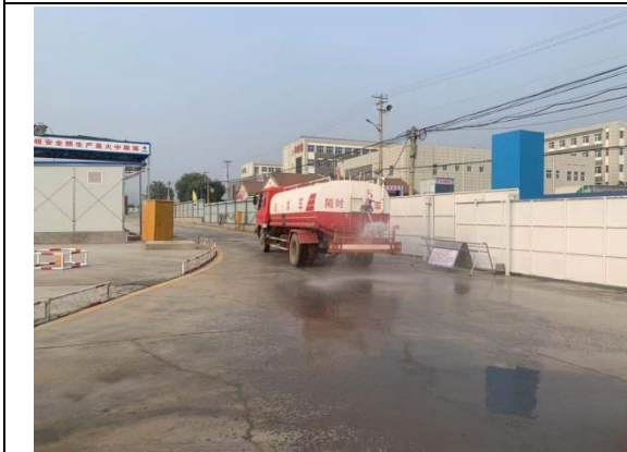
临时措施：洒水降尘
