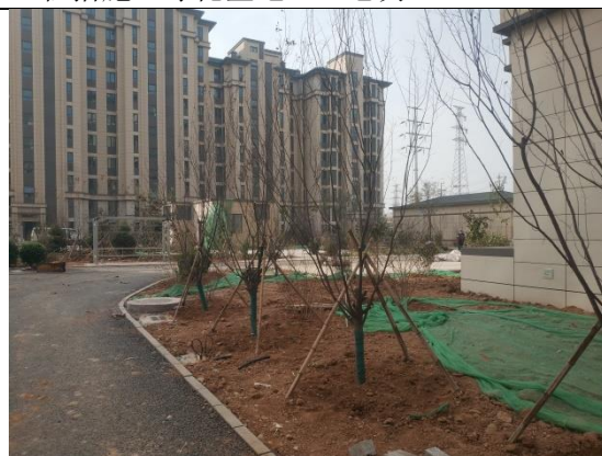
工程措施：绿化整地（D地块）
