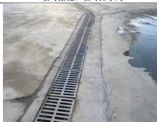
临时措施：临时排水沟
