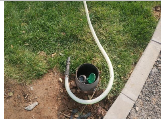
工程措施：节水灌溉（E地块）
