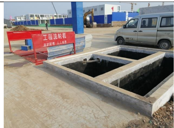
临时措施：洗车沉淀池
