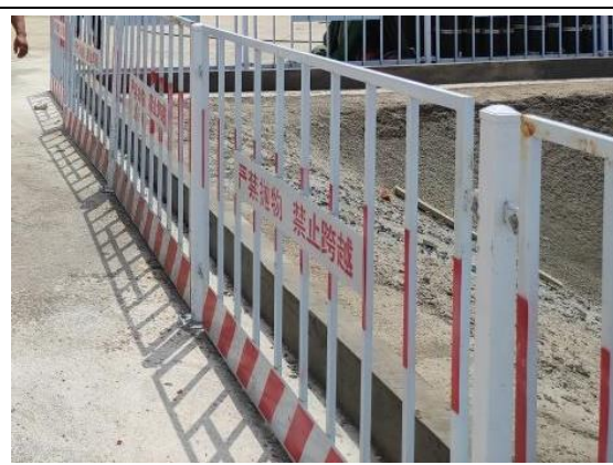
临时措施：基坑挡水梗
