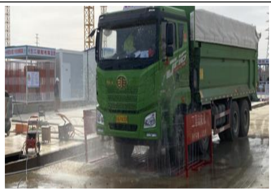
临时措施：洗车沉淀池
