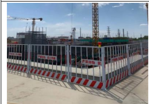
临时措施：基坑挡水梗
