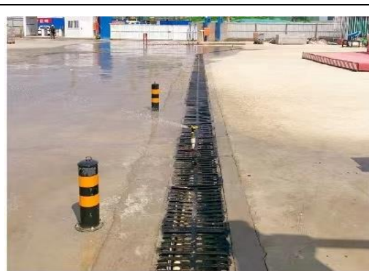
临时措施：临时排水沟
