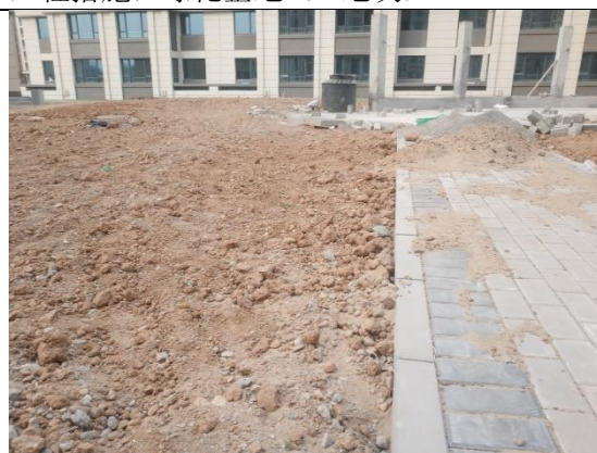
工程措施：绿化整地（C地块）
