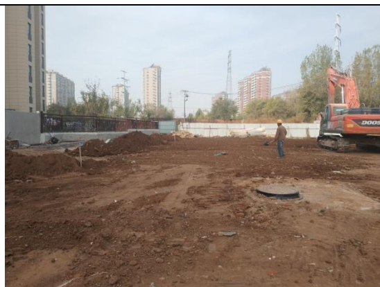
工程措施：临时用地土地整治
