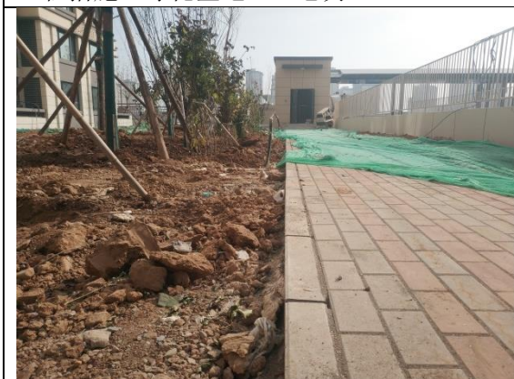
工程措施：绿化整地（D地块）
