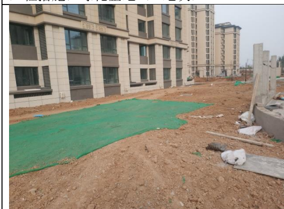
工程措施：绿化整地（C地块）
