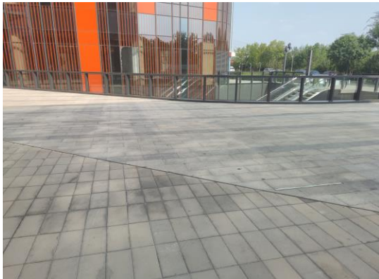
图3-2 透水砖铺装（一）
