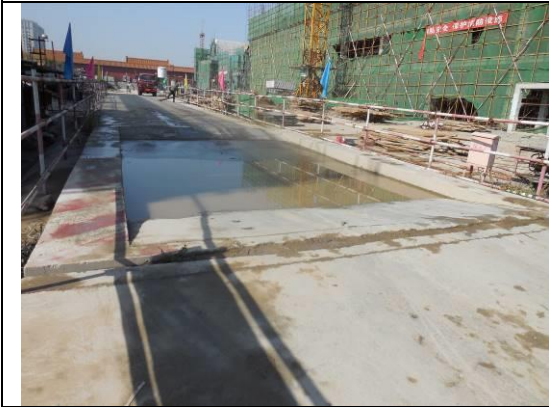
图15 施工出入口清洗凹槽
