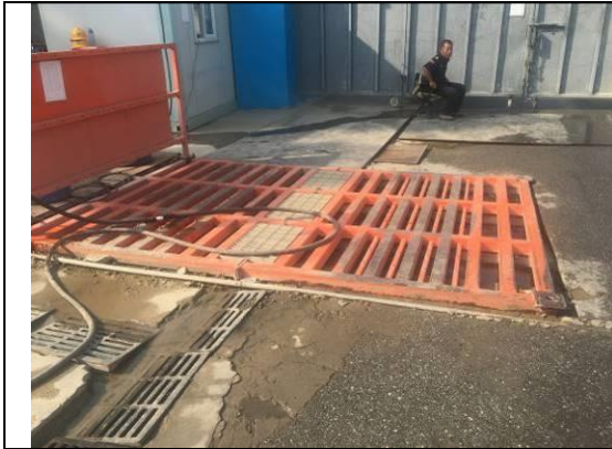
图4-15 施工出入口清洗凹槽及沉砂池
