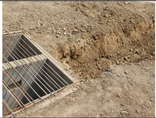
图4-16 临时排水沟、沉砂池
