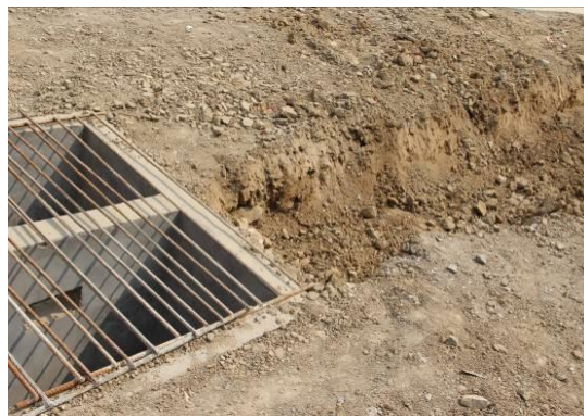
图3-16 临时排水沟、沉砂池
