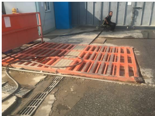
图3-15 施工出入口清洗凹槽及沉砂池
