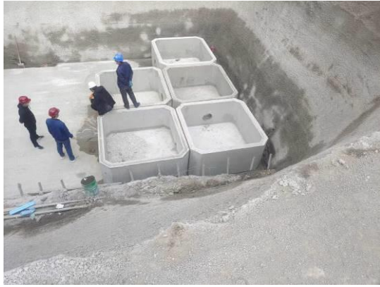
图7 集雨池 (400m 3 ) 施工 (2)
