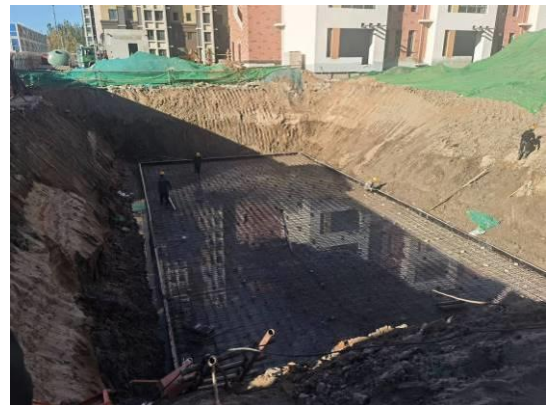
图3-12 集雨池 (750m 3 ) 施工 (1)
