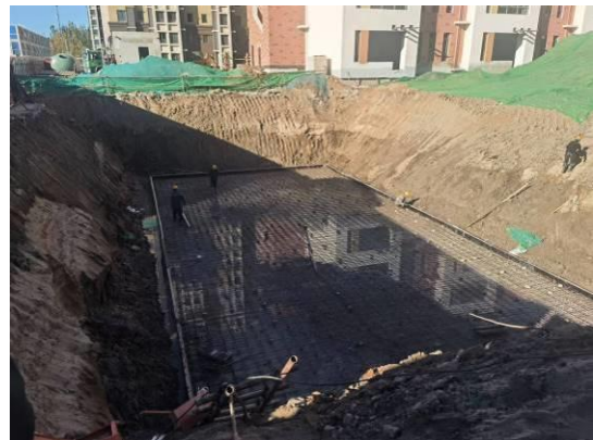
图10 集雨池 (750m 3 ) 施工 (1)
