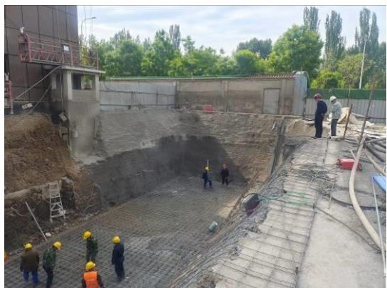
图3-8 集雨池 (400 m^3 ) 施工 (1)
