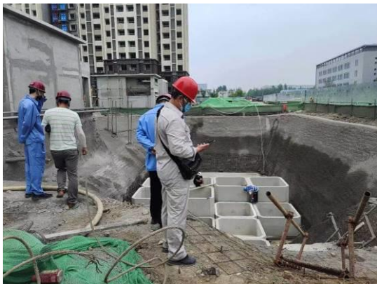
图3-11 集雨池 (485m 3 ) 施工 (2)
