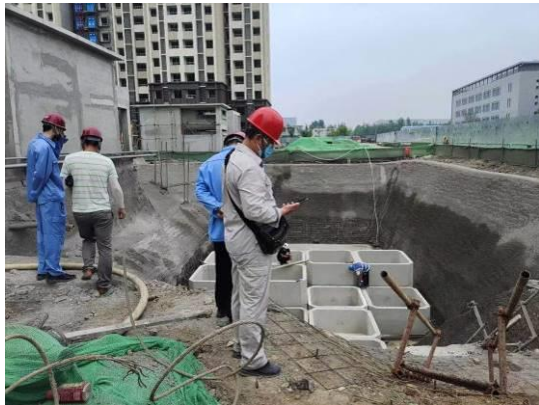
图9 集雨池 (485m 3 ) 施工 (2)
