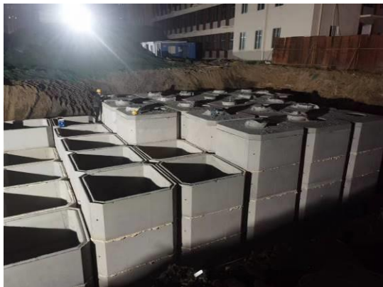
图11 集雨池 (750m 3 ) 施工 (2)
