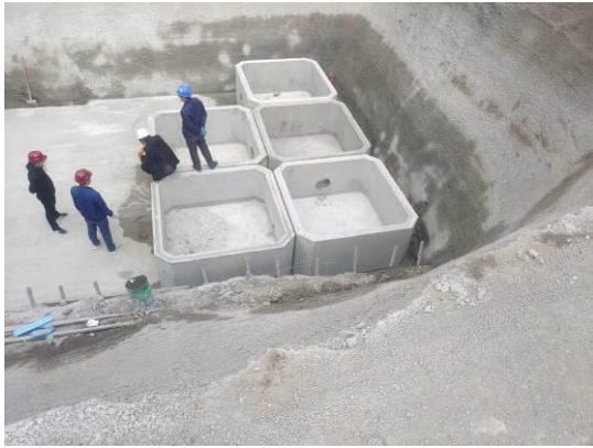
图3-9 集雨池 (400m 3 ) 施工 (2)
