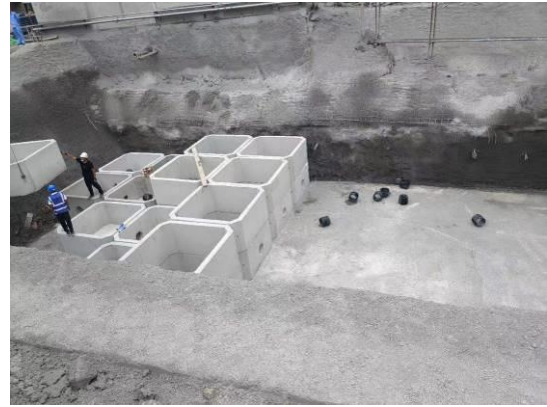
图3-10 集雨池 (485m 3 ) 施工 (1)
