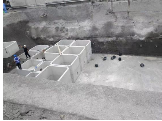
图8 集雨池 (485m 3 ) 施工 (1)
