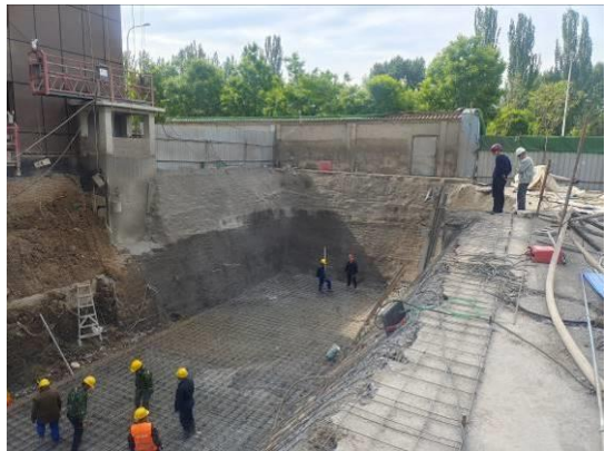
图6 集雨池 (400m 3 ) 施工 (1)
