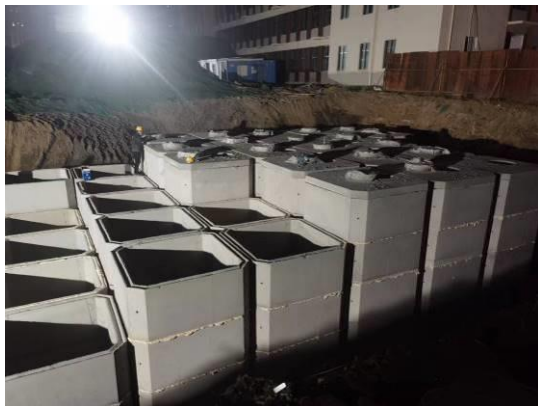
图3-13 集雨池 (750m 3 ) 施工 (2)
