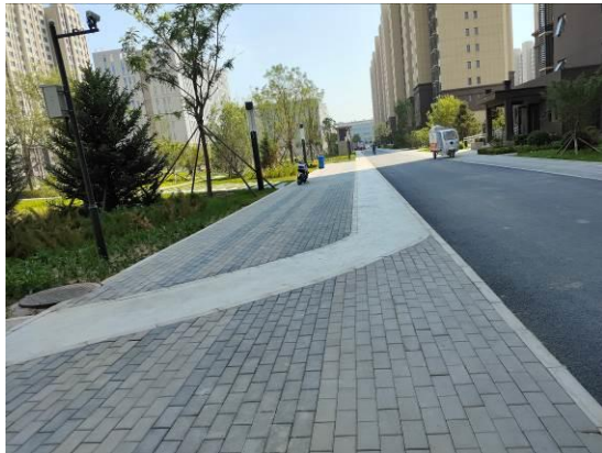
步行道透水砖铺装（2023年6月）
