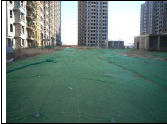
图4-23 临时苫盖（2016年12月）
