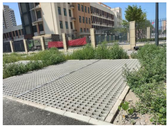
停车场植草砖铺装（2023年6月）
