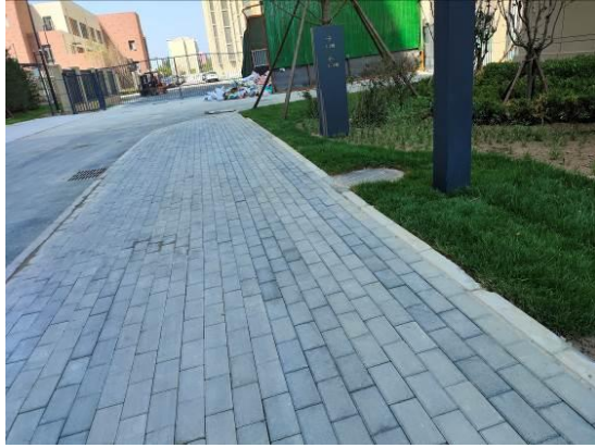
步行道透水砖铺装（2023年6月）
