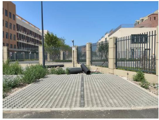
停车场植草砖铺装（2023年6月）
