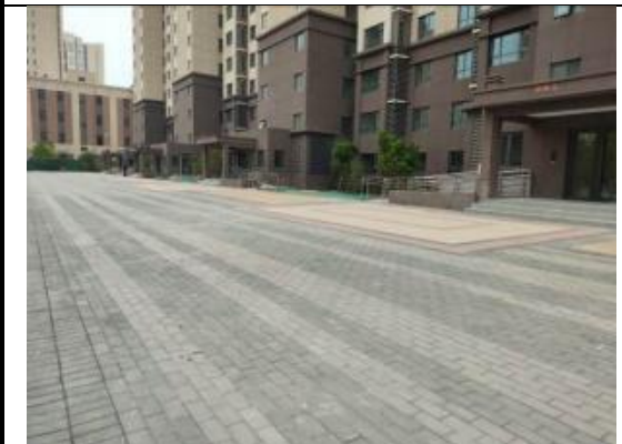
图4-7 宅前路透水砖铺装 (2023年4月)
