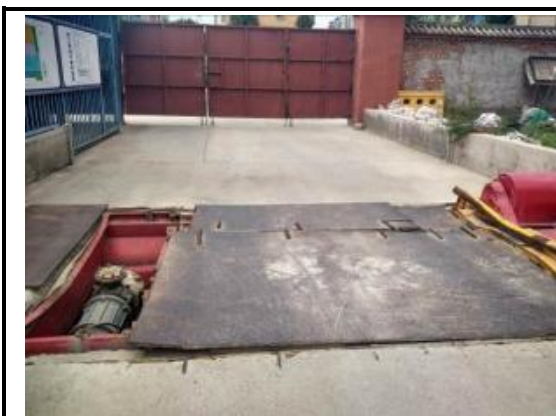
图4-21 入口处车辆清洗槽（2016年8月）
