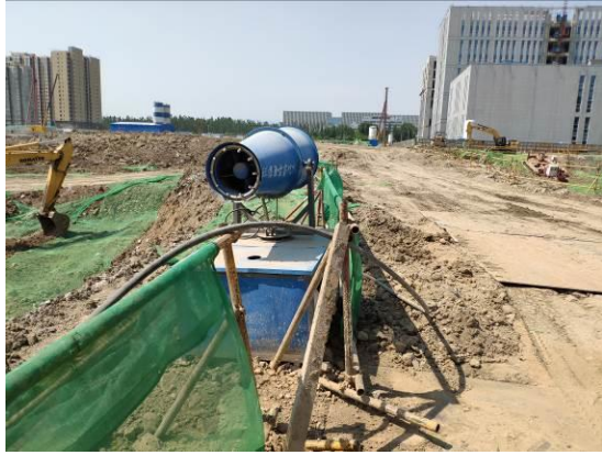
洒水除尘（2019年5月）
