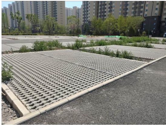
停车场植草砖铺装（2023年6月）
