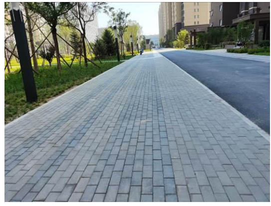
步行道透水砖铺装（2023年6月）
