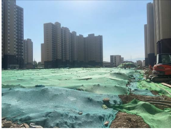
临时苫盖（2023年2月）
