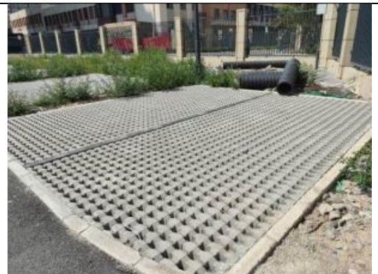
图4-8 停车场植草砖铺装 (2023年6月)
