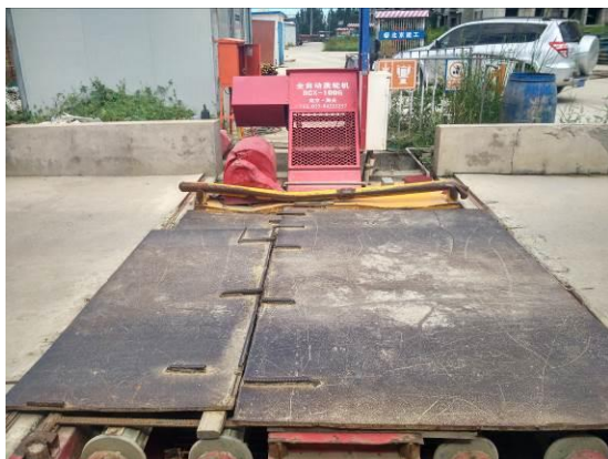
入口处车辆清洗槽 (2016年8月)
