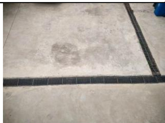
图4-22 施工便道两侧简易排水沟（2016年8月）
