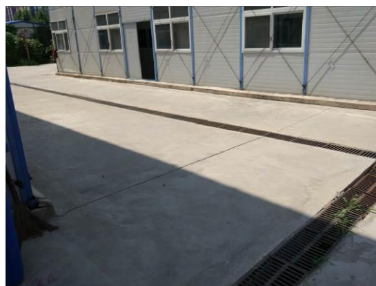
临时排水沟 (2017年8月)
