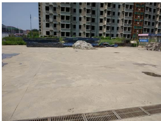
施工便道两侧简易排水沟 (2017年8月)
