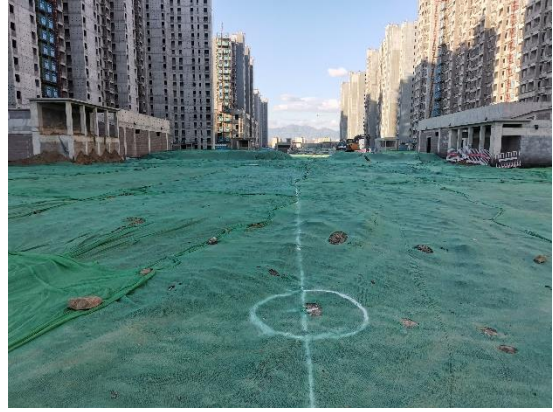
临时苫盖 (2022年1月)
