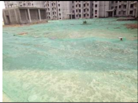
图4-24 临时苫盖（2016年12月）
