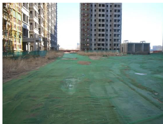
临时苫盖 (2016年12月)
