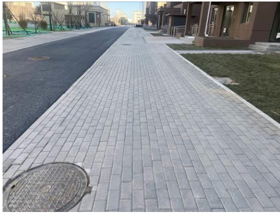
宅前路透水砖铺装（2023年2月）
