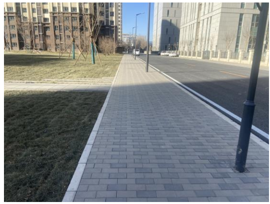
步行道透水砖铺装（2023年2月）
