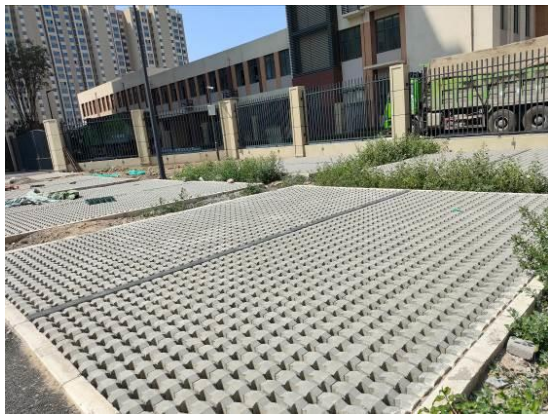
停车场植草砖铺装（2023年6月）
