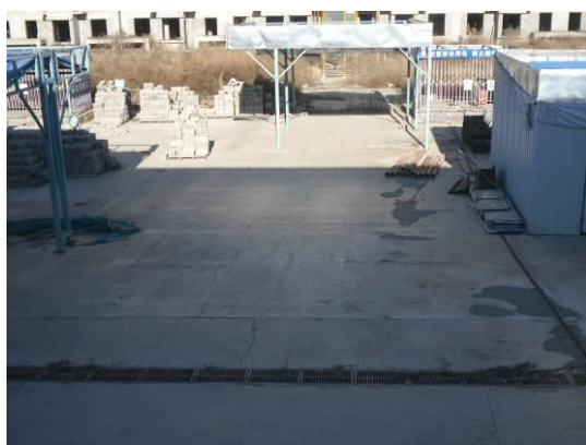
施工便道两侧简易排水沟 (2016年12月)
